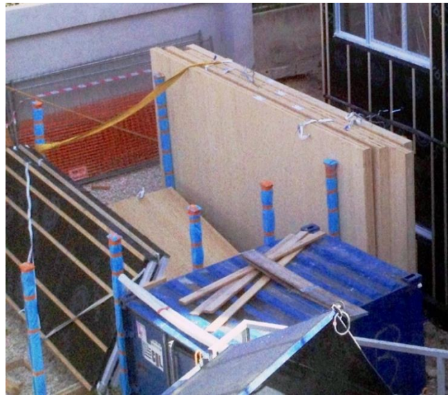
Figure 26 – Exemple de stockage vertical sur chantier de murs CLT (Source ARBONIS)
