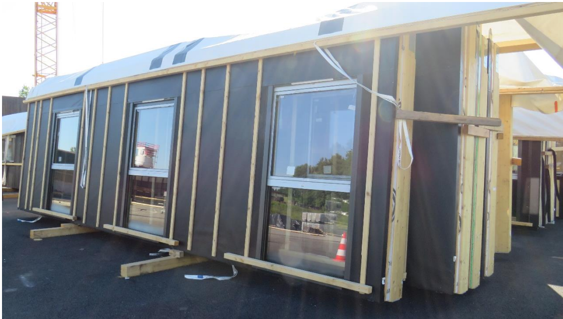
Figure 30 - Photo d'une protection de murs à ossature bois préfabriqués stockés verticalement (Source Arbonis)
