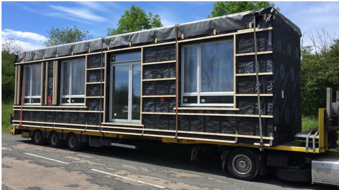
Figure 23 Photo d'un transport d'un module 3d protégé des intempéries (Source Arbonis)
