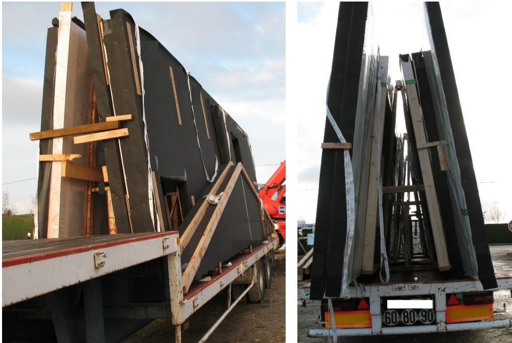
Figure 22 – Photos d'un transport de murs à ossature bois protégés intrinsèquement des intempéries par le pare-pluie et le pare-vapeur du mur (Source Arbonis)
