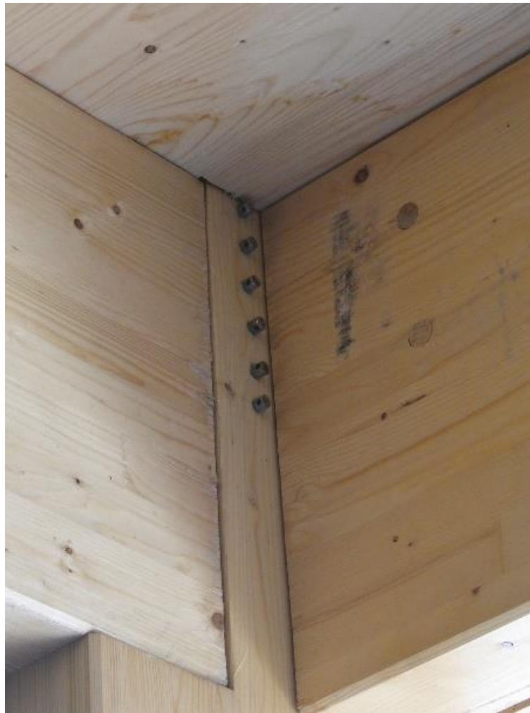
Figure 12 – Des sondes sont positionnées à différentes profondeurs d'une poutre en bois afin de contrôler l'évolution de son humidité (Source AQC [34])
