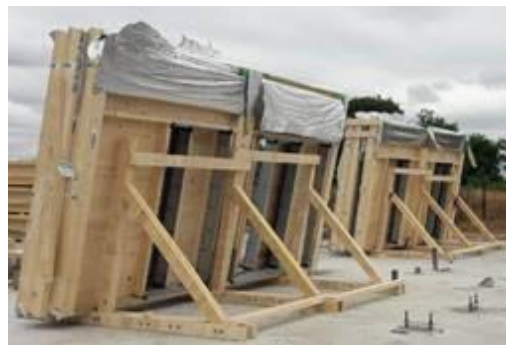
Figure 27 – Exemple de stockage sur chevalet de panneaux de murs (Source MATHIS)
