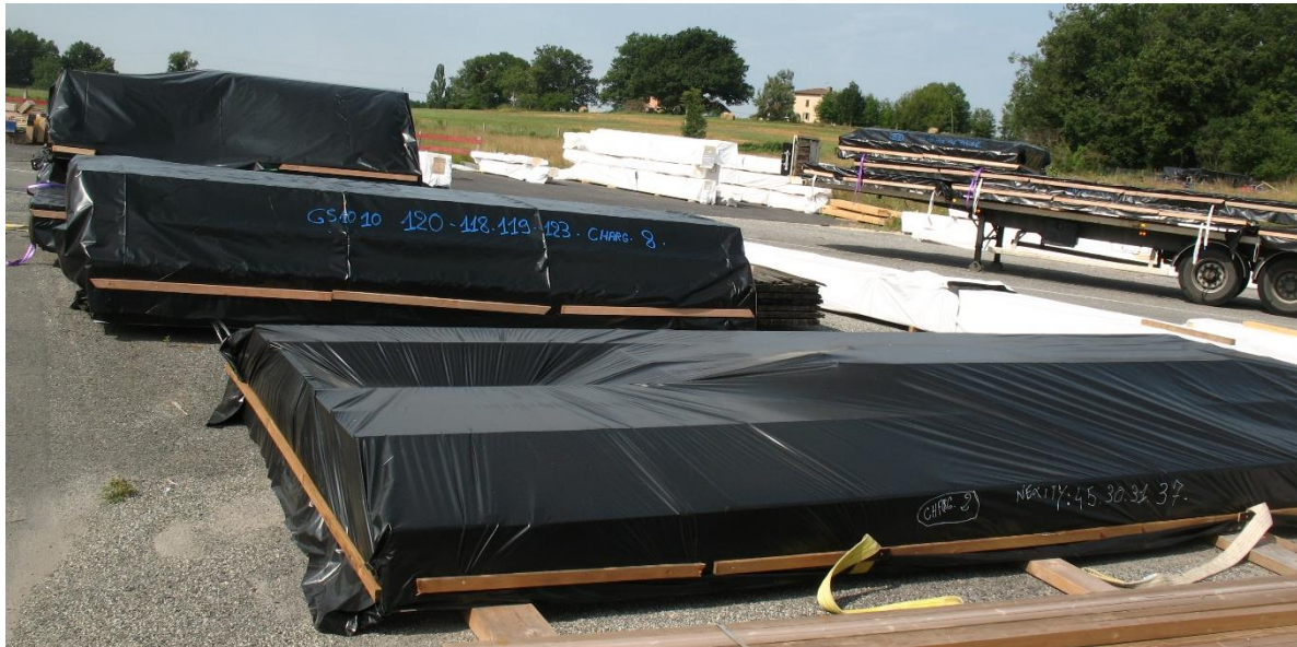
Figure 28 - Photo d'une protection d'éléments stockés sur chantier (Source Arbonis)
