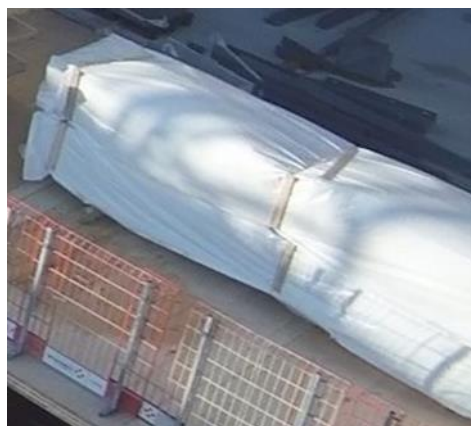
Figure 29 - Photo d'une protection de poutres et poteaux en bois lamellé collé stockés provisoirement en étage (Source MATHIS)
